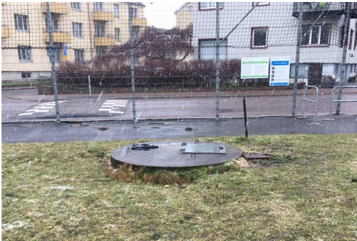
Foto 5. Pumpstation i sydöst
